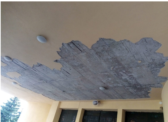
Zdj. 6. Odpadający tynk nad wejściem głównym do kościoła
