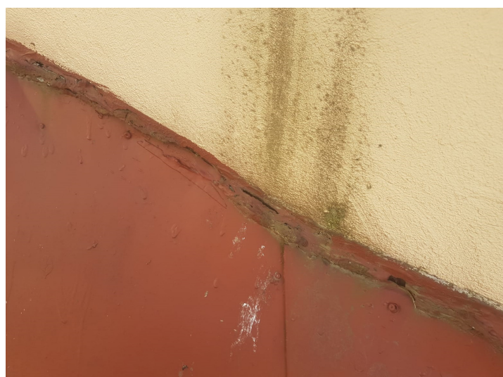
Zdj. 2. Niedoróbki blacharskie na dachu
