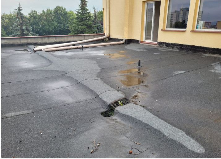
Zdj. 4. Taras nad wejściem głównym
