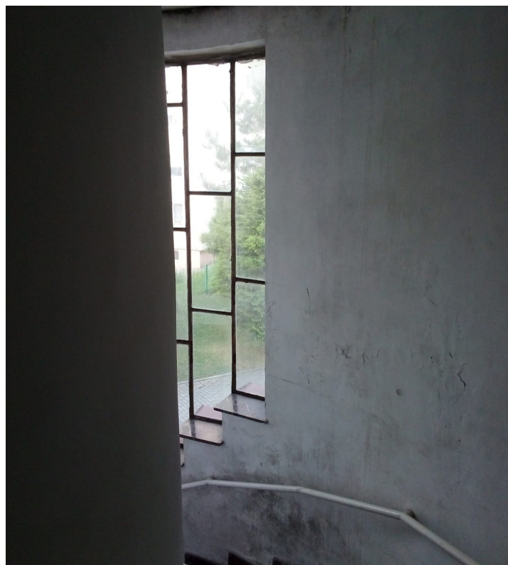
Zdj. 3. Wilgoć na schodach wiodących na chór
