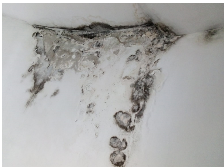
Zdj. 1. Grzyb na suficie przy wejściu na chór nad kaplicą Matki Bożej
