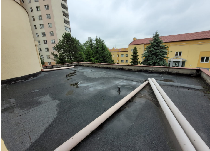
Zdj. 5. Odprowadzenie wody na tarasie
