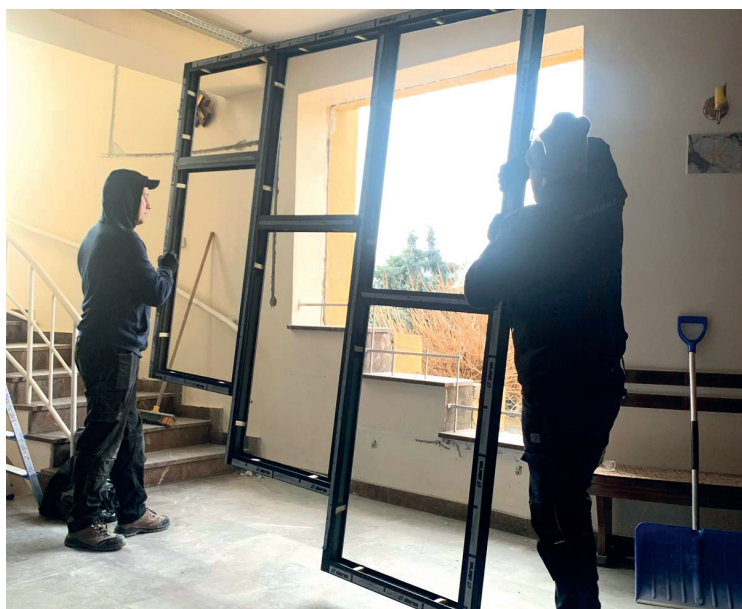
Wkładanie nowych ram pod witraże
