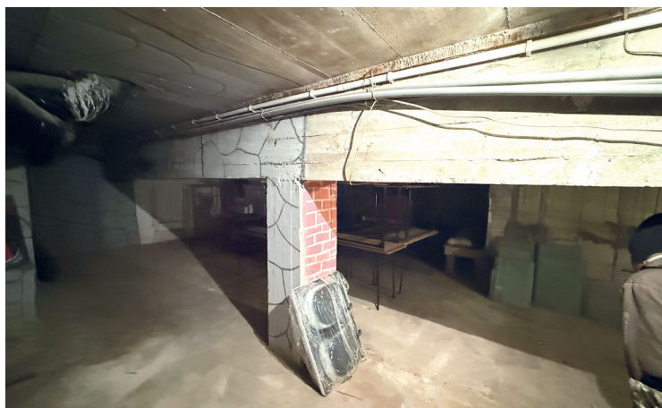
Opróżnione pomieszczenia pod kościołem i przygotowanie miejsca pod prace instalacyjne i izolacyjne
