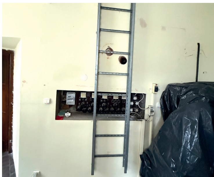
Przygotowane umocowania nowej szafy z centralą elektryczną
