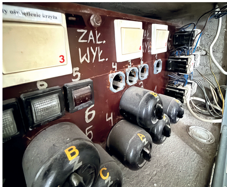
Stara centrala w zakrystii do sterowania częścią oświetlenia
