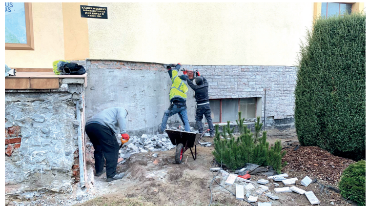
Przygotowanie izolacji i docieplenia fundamentów
